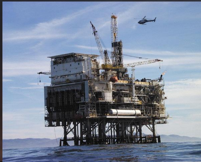
پلتفرم حفاری رویال داچ شل، در دریای شمال
